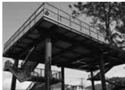
完成した津波避難タワー
