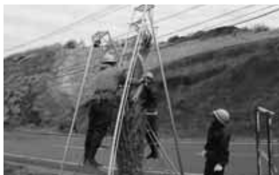
コモ外し作業をする作業員ら
