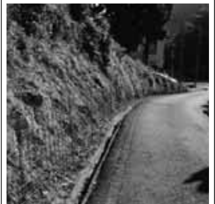
材料支給による施工（上小野区）
