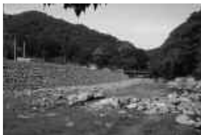
※平成27年度工事完成後の様子
