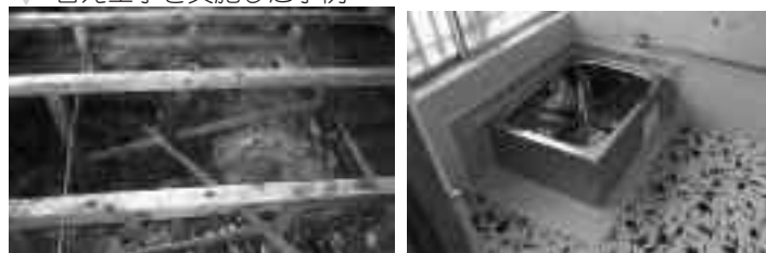
▲ 浴室改修した事例
