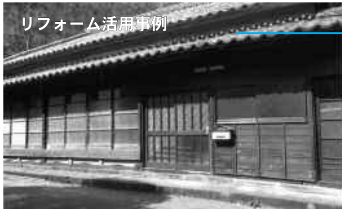
▲ リフォーム等補助金を活用して、屋根工事、フローリング張り替え工事を実施した事例
