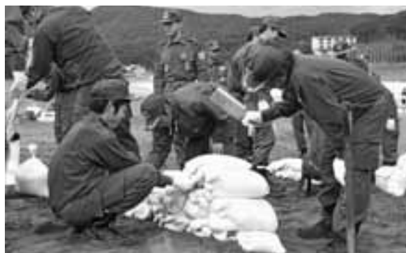
積んだ土のうを整形する様子
