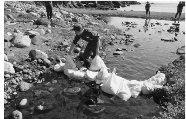
土のうを設置し、川の水をせき止める消防団員
