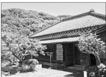
お試し住宅の外部の様子です。 多様な植物が植えてあります。
