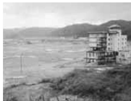
派遣先の山田町に隣接する宮古市田老地区。地上三階まで被災しています。
