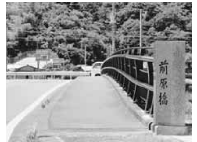
リニューアルされた前原橋の欄干
