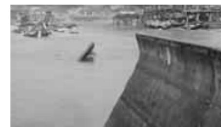
津波により破壊された防波堤(船越半島)
