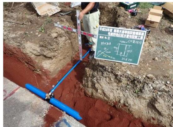
給水管布設替の様子（ホリレイン管）
