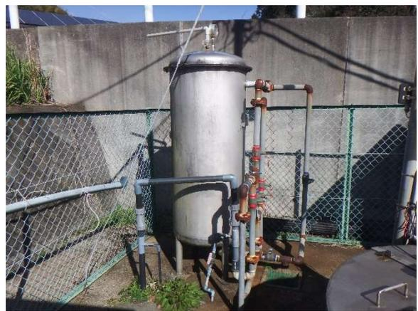
一條低区ろ過機(除鉄・除マンガンろ過機)
