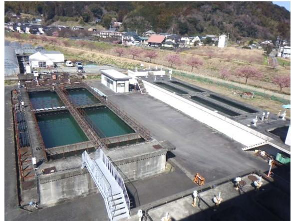
石井浄水場(1系・2系薬品沈殿池)
