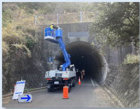
【丸山トンネル点検状況】
