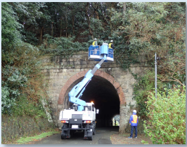
【彌陀山隧道点検状況】
