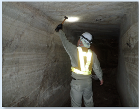
【平戸隧道点検状況】
