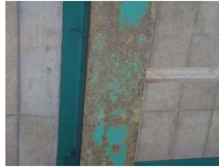
鋼橋の損傷(錆の発生)
