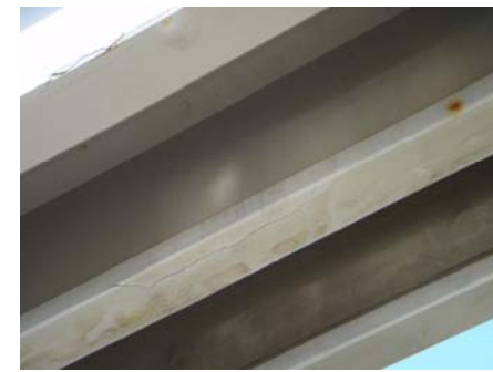
コンクリート橋の損傷(ひびわれ)
