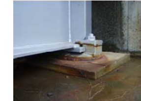
支承腐食修繕
