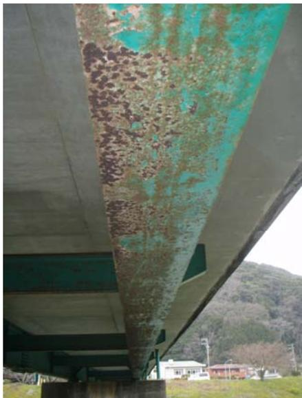
主桁下フランジ腐食（宮前橋）
