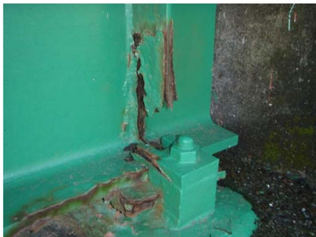
支点上補剛材の欠損（上谷戸橋）
