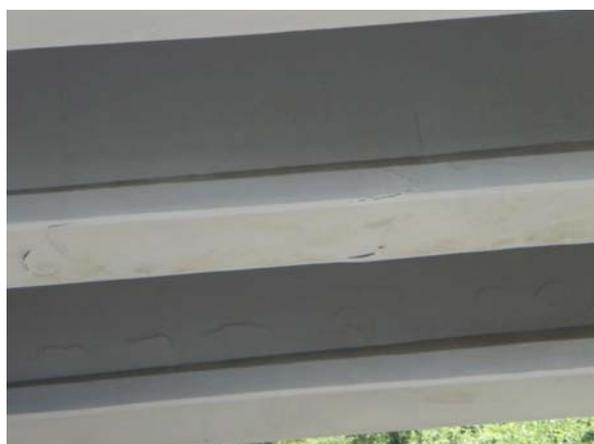
主桁 ひび割れ コンクリート浮き (宇留井大橋)
