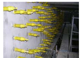
ドローンを利用した点検 (近接目視支援) リハビリシリンダー工法 (ひび割れ注入)
