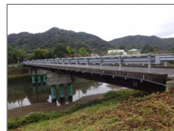
措置が完了した橋梁
