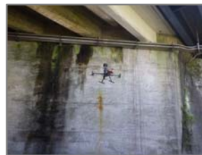
ドローンを利用した点検 (近接目視支援) リハビリシリンダー工法 (ひび割れ注入)
