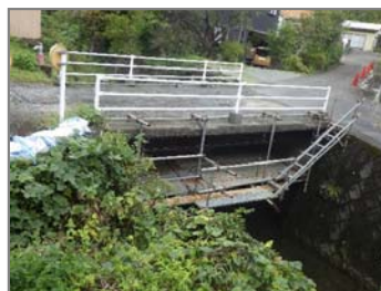
補修工事中の橋梁
