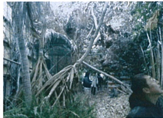
建物内部の様子
