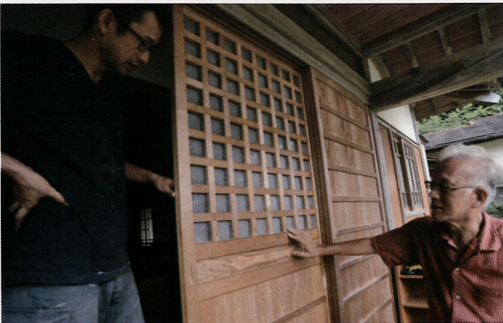
格子部分を互い違いに組み込んでいる西子浦の海蔵寺の戸。薄い木の皮や竹ひごによる網代編みというのは有名だが、堅い木で組んでいくのは至難の技。
